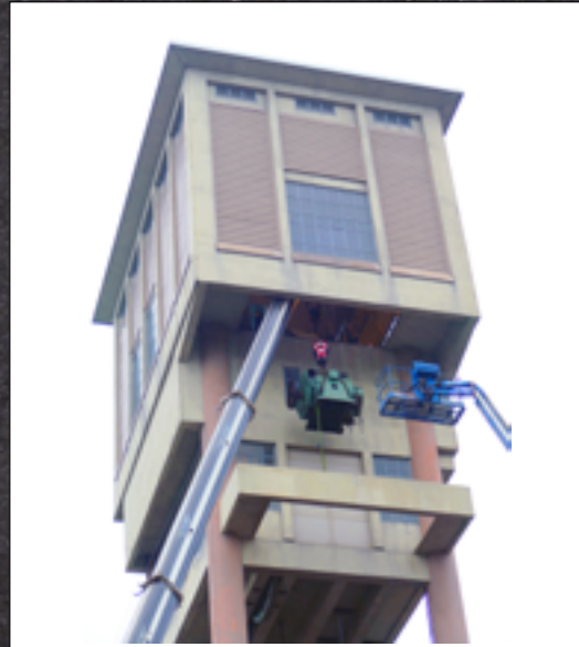
Remplacement du moteur de la machine d'extraction
