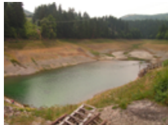
Réservoir d'eau © Karasini 2005
