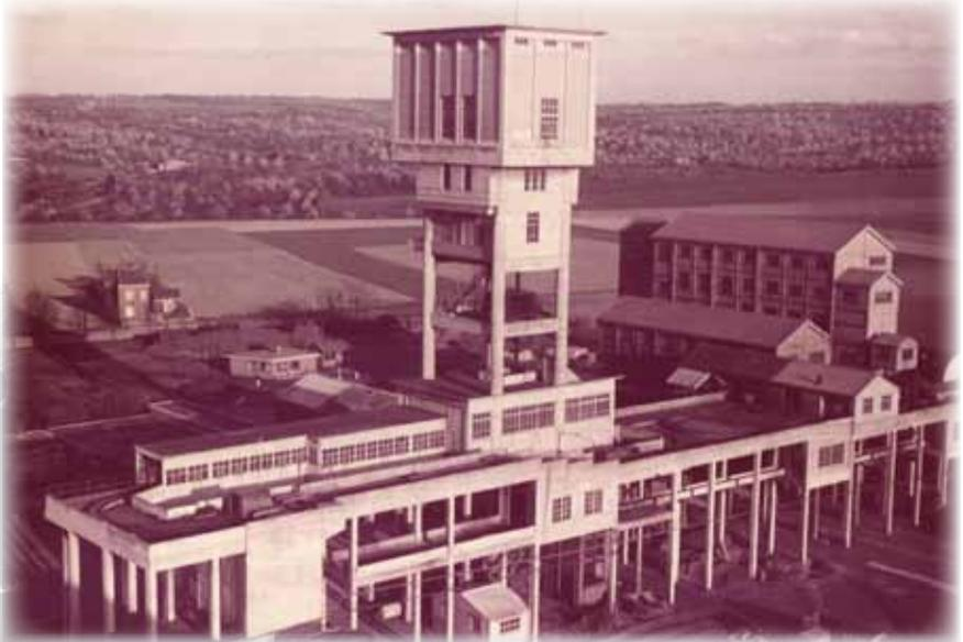
Vue d'ensemble vers 1960 du Puits N°1, de la recette (pas encore couverte) et du triage-lavoir © Fonds Ausselet - Collection Blegny-Mine
