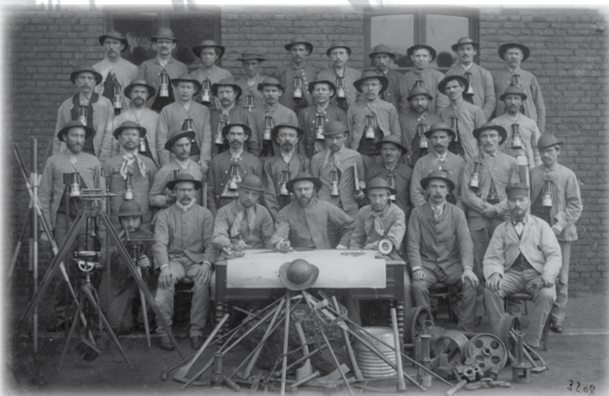
Groupe de mineurs et techniciens avec matériel de géomètre à la S.A. des charbonnages du Val Benoît, siège Val Benoît, en 1886. Photo Charles-Honoré Lallement
