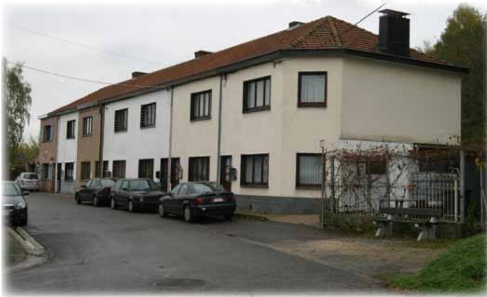
Habitations rue Belle-Fleur, à l'arrière de Blegny-Mine © Blegny-Mine Les façades, aujourd'hui crêpies, étaient initialement faites de blocs apparents.
