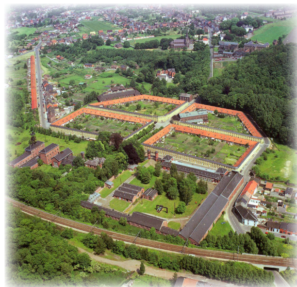
Site minier du Bois-du-Luc Copyright : G. Focant/SPW
