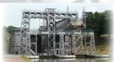
Les ascenseurs du Canal du Centre © Rubens Jacquelin
