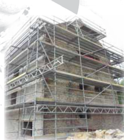
Le bâtiment de la machine à feu de Bernissart, en pleine rénovation
