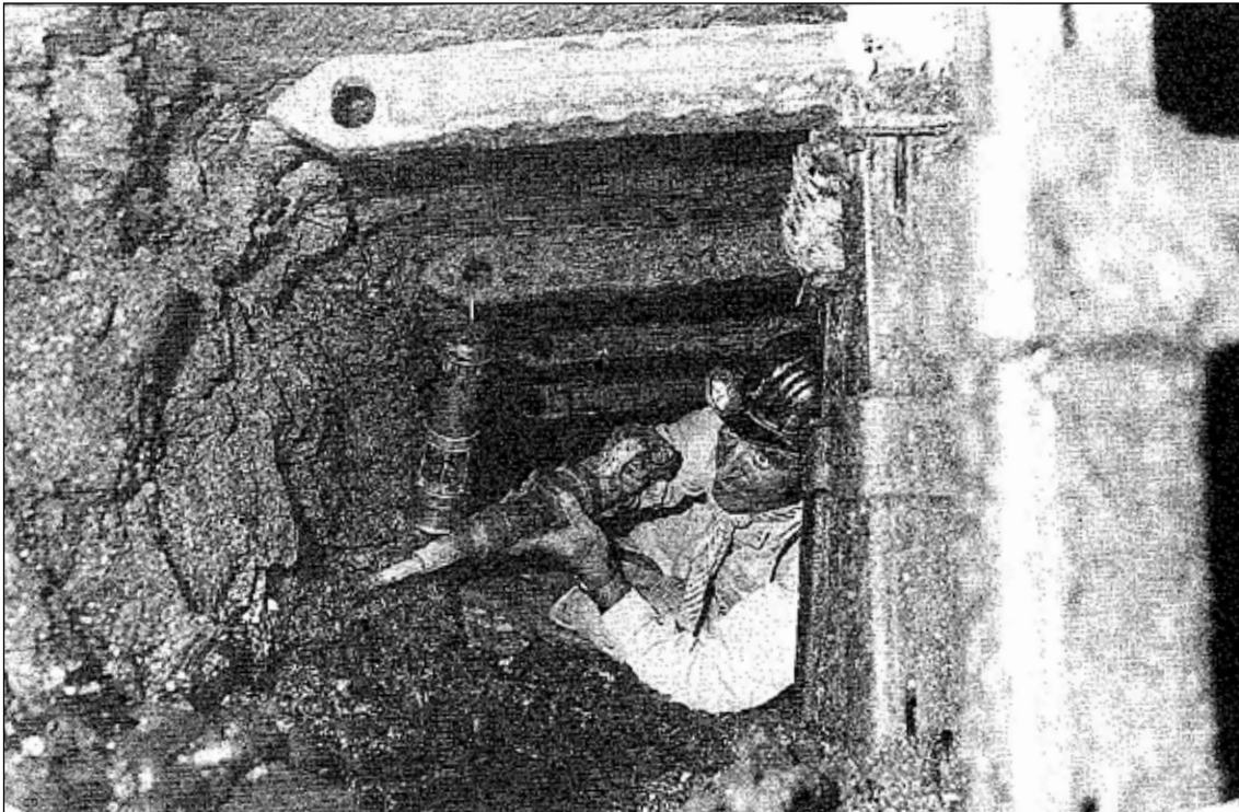
De ontginning met de drilboor.
