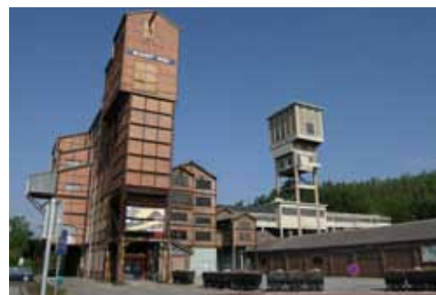
Le triage-lavoir et le puits n°1
