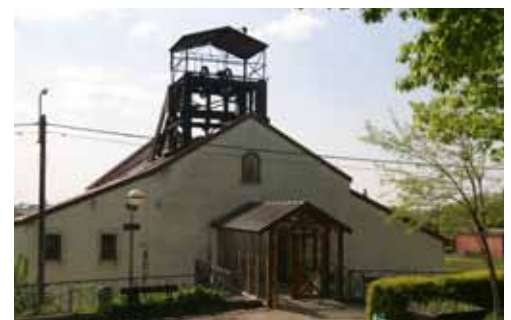
Vue actuelle du musée de la mine (Puits-Marie) © Blegny-Mine
