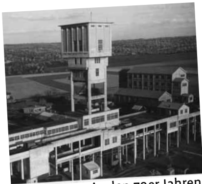
Schacht Nr. 1 in den 70er Jahren Pit No. 1 in the 1970s. © Fonds Ausselet
